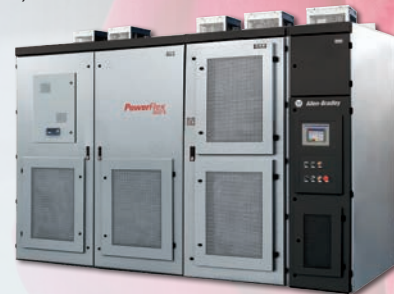
Przeмиennik PowerFlex 6000 24-pulsowy (silniki o napięciu 4/4,16 kV)
